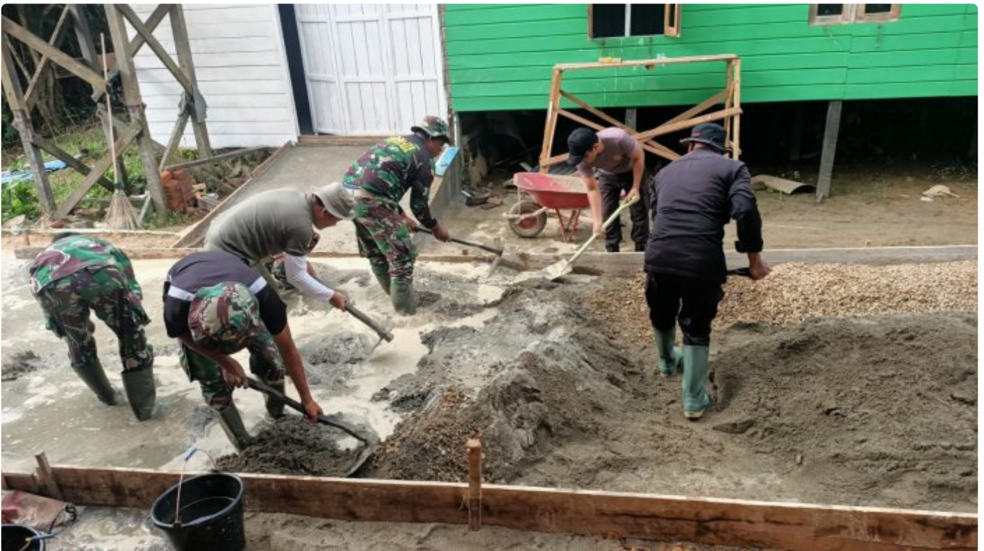
Aduk Semen Dengan Cangkul dan Skop Kebut Pembangunan Semenisasi Jalan TMMD
