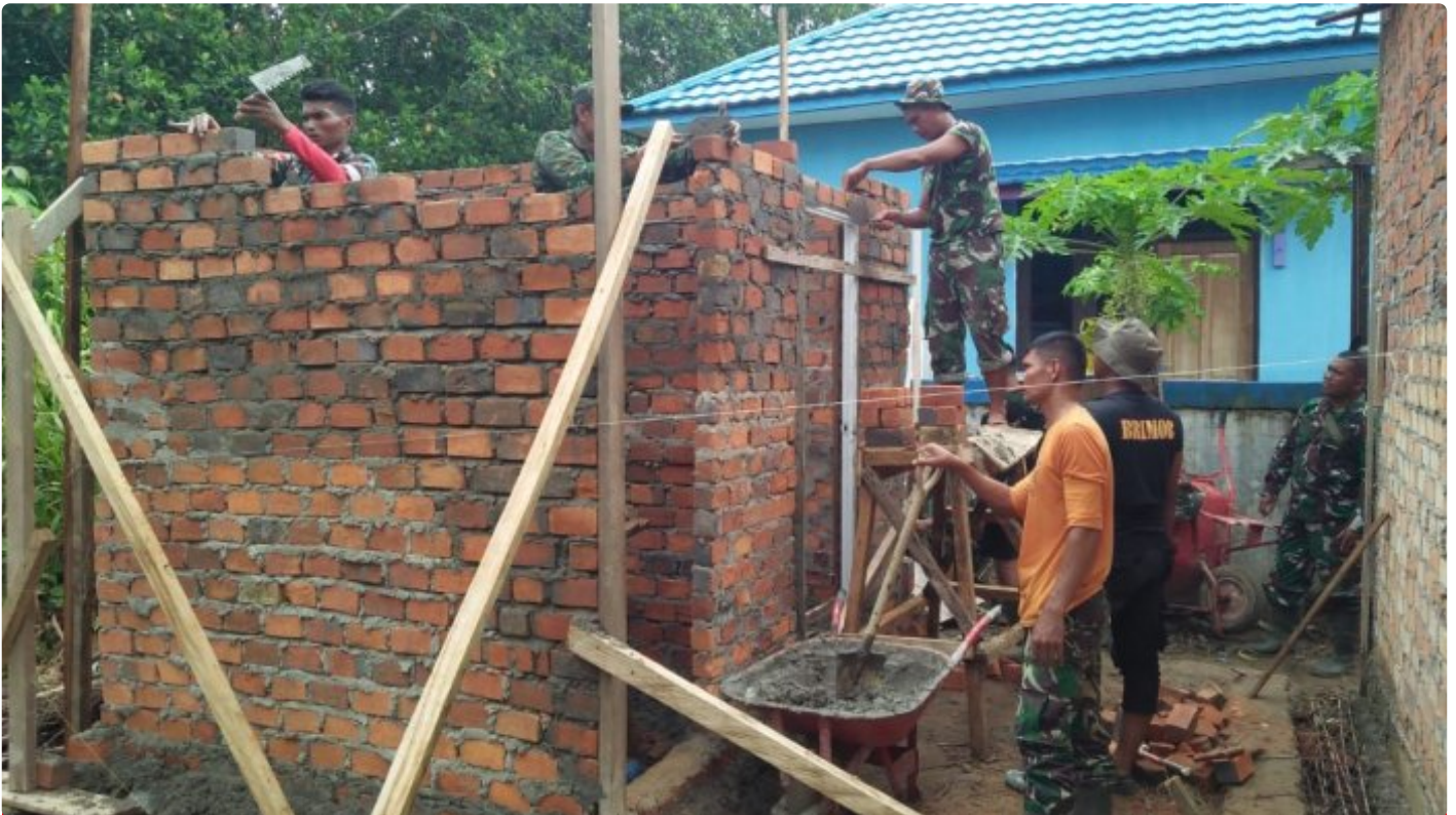
Pasiter Tinjau Proses Pekerjaan Sasaran Tambahan TMMD ke-118 Pembangunan MCK Gereja
