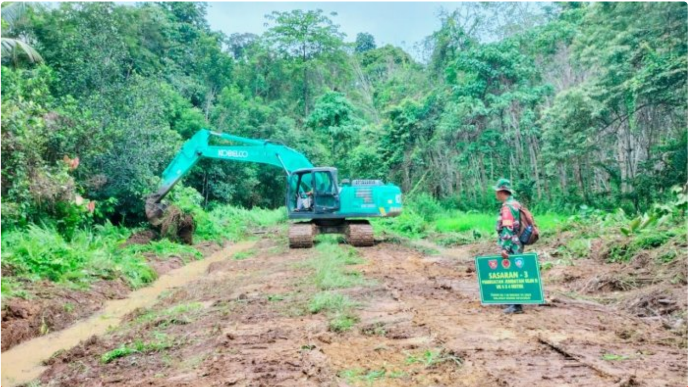
Progres sasaran fisik pembukaan badan Jalan TMMD ke-118 Capai 31 Persen
