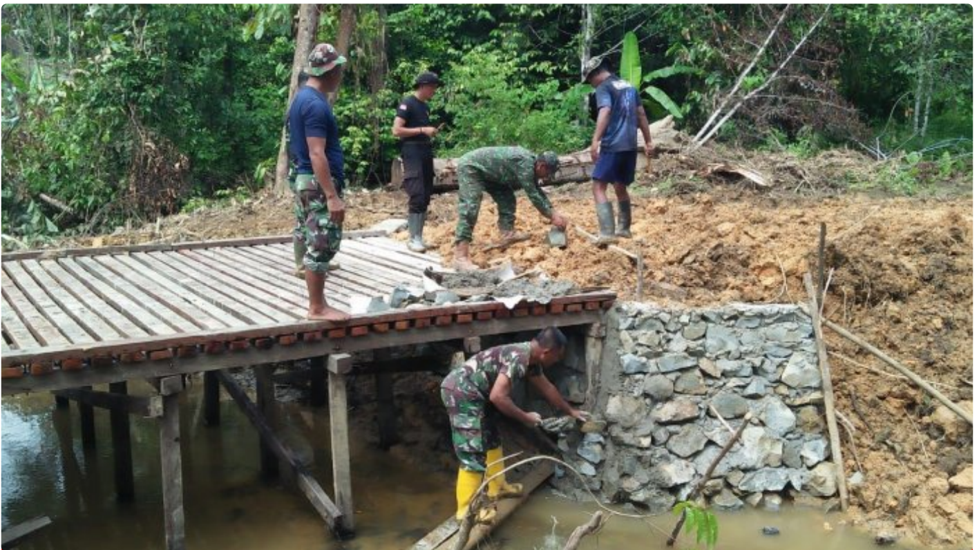
Progres Sasaran Jembatan Kayu Ulin TMMD Ke- 118 Wiltas Kodim/Malinau Capai 75 Persen
