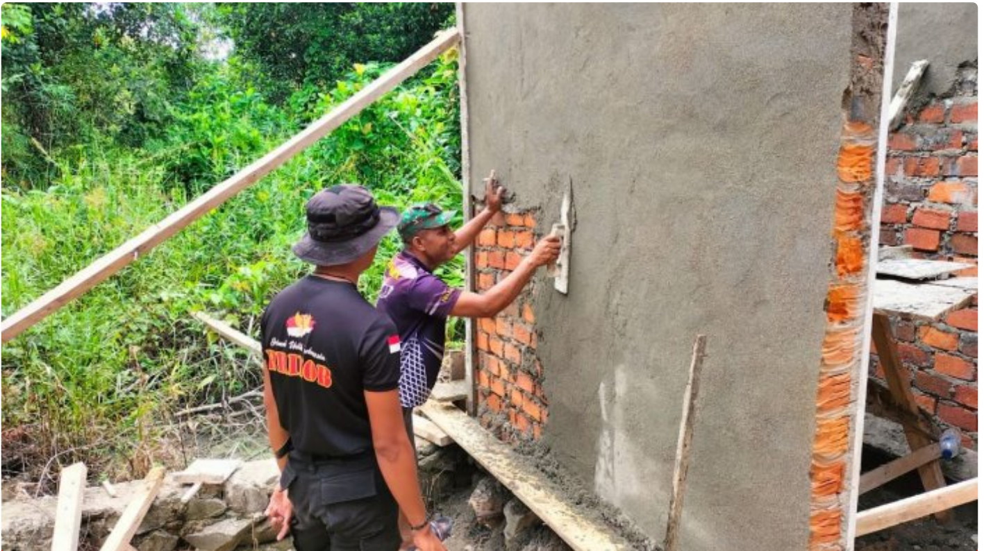
Satgas TMMMD Ke- 118 Wiltas Kodim 0910/Malinau Plester Dinding Pembangunan MCK Gereja
