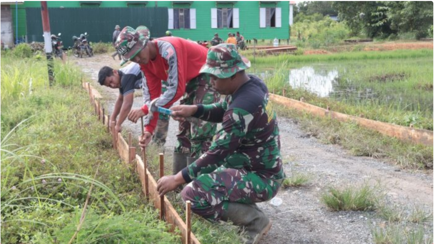
TMMMD ke- 118 Kodim 0910/Malinau Bantu Percepat Pembangunan Daerah
